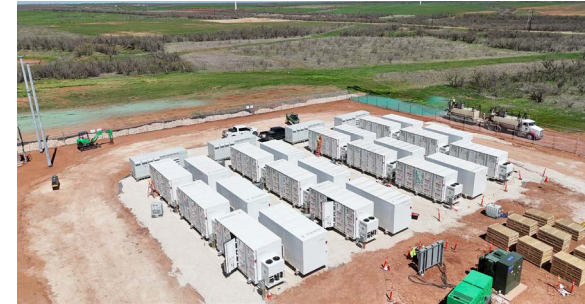
북미 협력회사와 협업을 통해 설치 중인 Texas 지역 내 50MWh의 Reuse ESS
